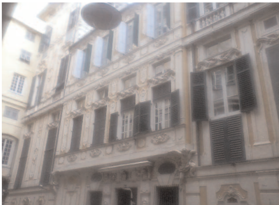
Facciata di Palazzo Spinola verso Piazza superiore di Pellicceria (Foto F.R)
