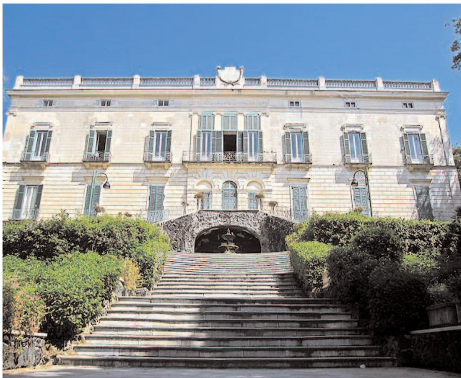
Villa Floridiana, Napoli. La facciata sud rivolta verso il mare (WCL)
